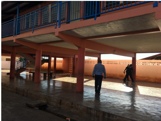
Fig. 45 : Ecole maternelle « Sada I M'Tsangani », ossature béton armé avec remplissage en maçonnerie R+1. RDC transparent. Quelques poteaux en béton fissurés en leur centre dans le sens de la hauteur et à leur pied. (degré 1 à degré 2 pour une vulnérabilité estimée à B)
