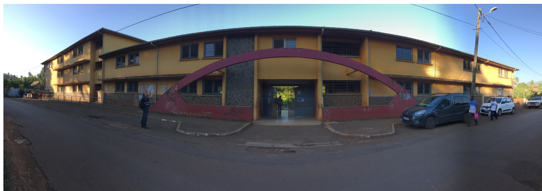
Fig. 17 – Ecole primaire Matsabouri, vulnérabilité C, endommagement de degré 1 (photo-CS-BCSF).
