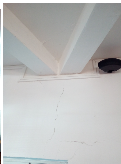
Fig. 46 : La mosquée qui jouxte l'école « Sada I M'Tsangani », structure ossature béton armé « en étoile » avec un remplissage en maçonnerie pour les parois extérieures. Droite : poutres reposent directement sur les murs en maçonnerie induisant une fissuration avec ouvertures. Dégâts de degré 2 pour une vulnérabilité estimée B.
