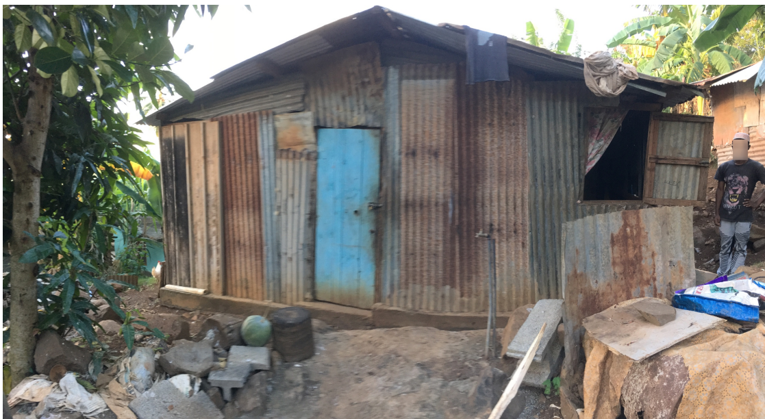
Fig. 36 – Exemple d’habitat de fortune en tôle, sans endommagement - quartier de Fouboudi, (Photo CS/BCSF).
