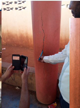
Fig. 45 : Ecole maternelle « Sada I M'Tsangani », ossature béton armé avec remplissage en maçonnerie R+1. RDC transparent. Quelques poteaux en béton fissurés en leur centre dans le sens de la hauteur et à leur pied. (degré 1 à degré 2 pour une vulnérabilité estimée à B)
