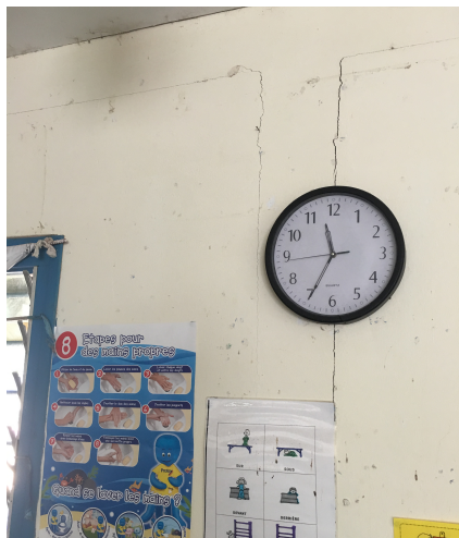
Fig. 27 : Ecole de M'Bouini avec fissures millimétriques à toutes les liaisons ossature/remplissage révélant toute la géométrie de l'ossature. Dégâts de degré 1 dans une structure de classe de vulnérabilité C. (photos-AS-BCSF).
