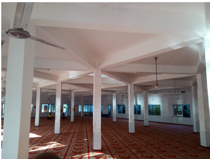
Fig. 46 : La mosquée qui jouxte l'école « Sada I M'Tsangani », structure ossature béton armé « en étoile » avec un remplissage en maçonnerie pour les parois extérieures. Droite : poutres reposent directement sur les murs en maçonnerie induisant une fissuration avec ouvertures. Dégâts de degré 2 pour une vulnérabilité estimée B.
