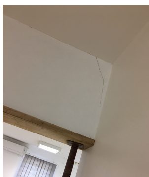
Fig. 39 – Mairie de Ouangani, endommagement de degré 2 (fissuration poutres porteuses). (Photo CS/BCSF)
