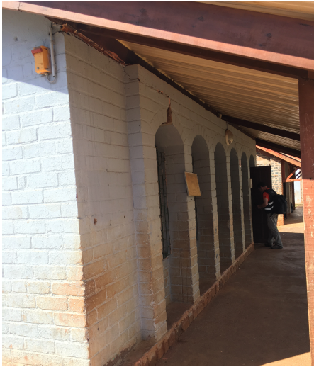
Fig. 24 – Ecole élémentaire de Hajangua type case SIM: Fissure liée au mouvement relatif de la charpente par rapport à la maçonnerie et perte de l'élément central d'une arche. Les dégâts sont de degré 2 pour une classe de vulnérabilité A.
