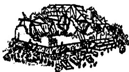
Dégâts de niveau 5
